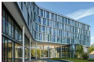
Bürogebäude Arabeska München
