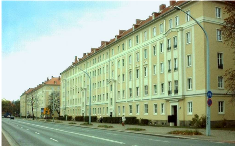
Sanierung von 4.000 Wohnungen in Dresden
