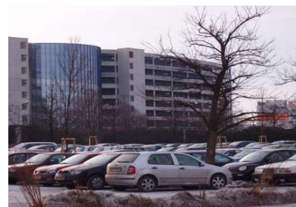
Aufstockung Parkhaus, Flughafen Wien
