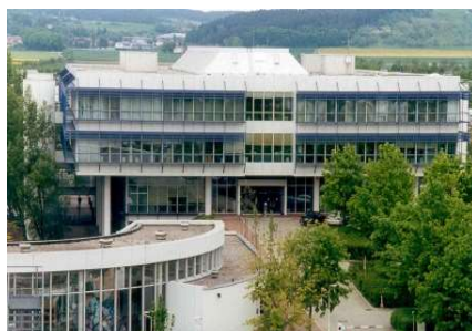
Generalsanierung Bürogebäude, BMW-Werk Dingolfing
