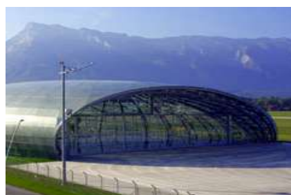
Hangar 7, Flughafen Salzburg
