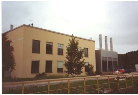
Energie- /Heizzentrale München Großlappen
