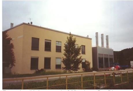
Energie- /Heizzentrale München Großlappen
