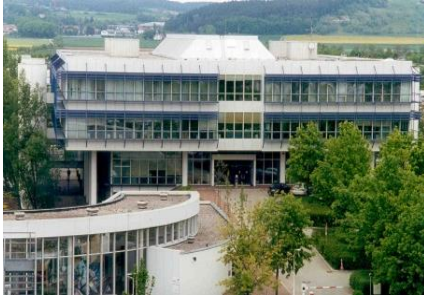
Generalsanierung Bürogebäude, BMW-Werk Dingolfing
