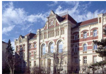
Sanierung und Umbau Büroräume, Wien
