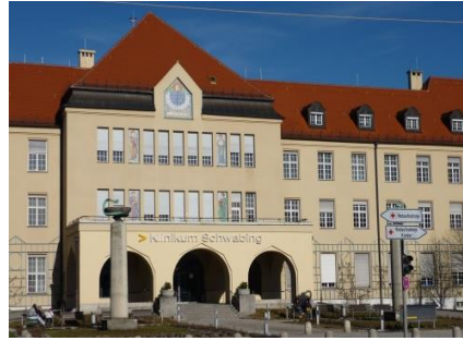
Krankenhaus Schwabing, München
