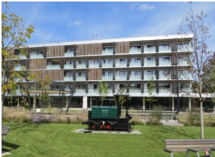
Geriatriezentrum Baumgarten, Wien
