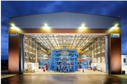
Testhalle, Flughafen Dresden
