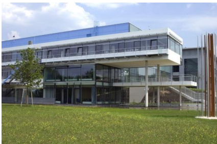
Reinraumgebäude, TU Ilmenau
