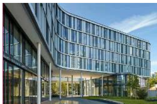
Bürogebäude Arabeska München
