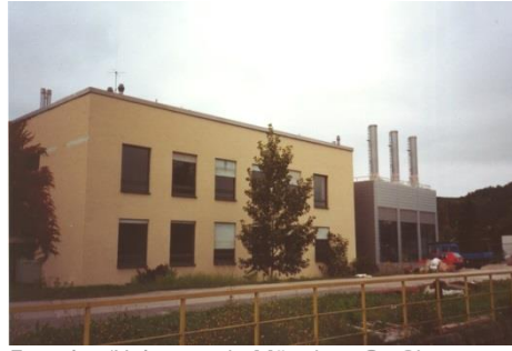
Energie- /Heizzentrale München Großlappen
